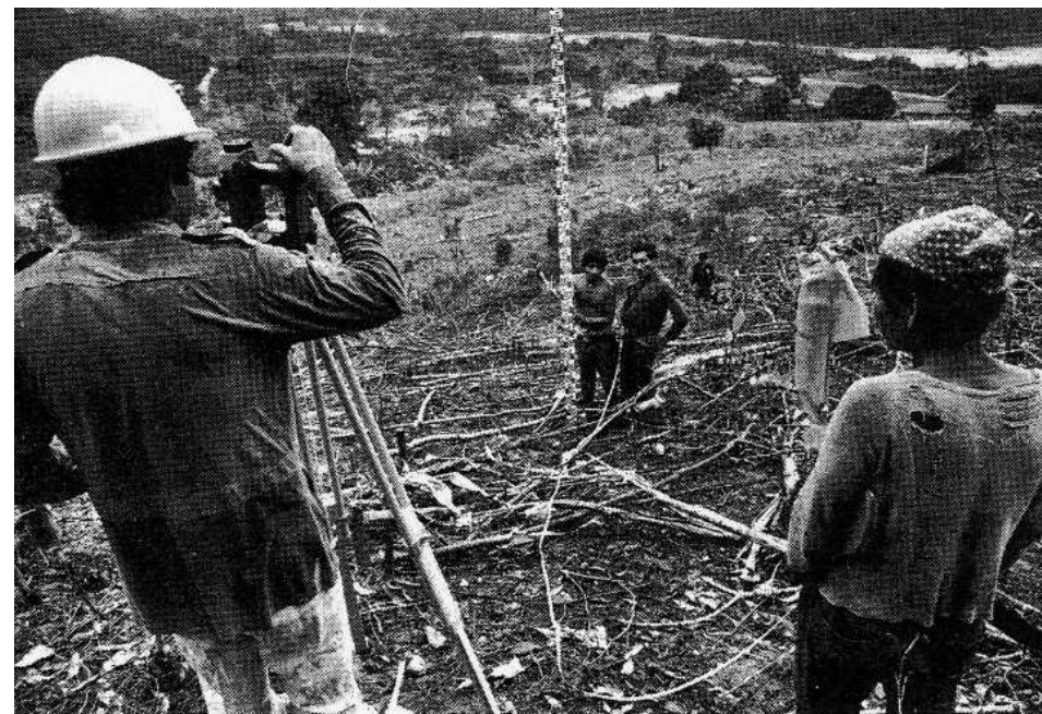
Levantamiento topográfico de la zona donde va a construirse la escuela. (Foto: Proyecto Boca Cheni)
