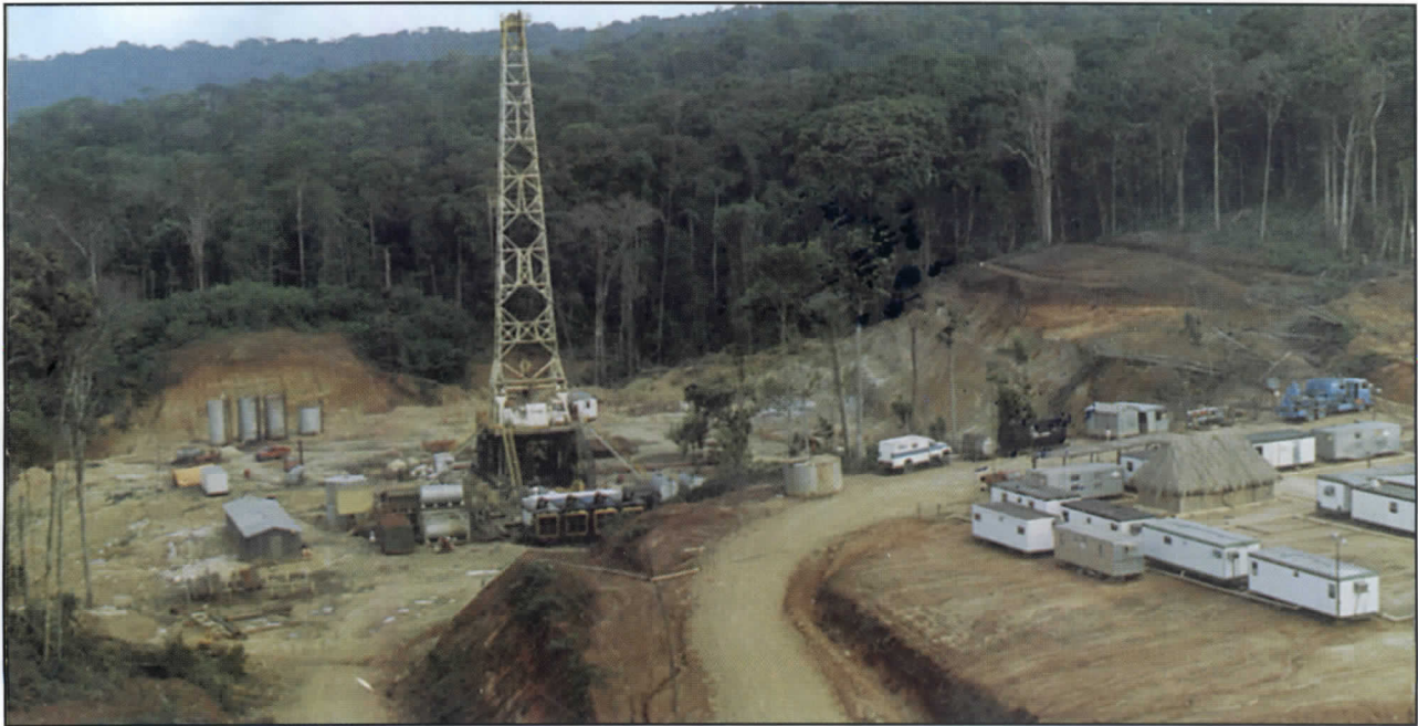
Una planchada desarrollada con campamento e instalaciones
