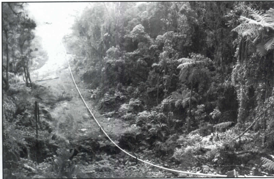
Foto antigua del Poliducto Cochabamba- Puerto Villarroel. La tubería atraviesa la cordillera oriental para llegar a una terminal sobre el río Ichilo
