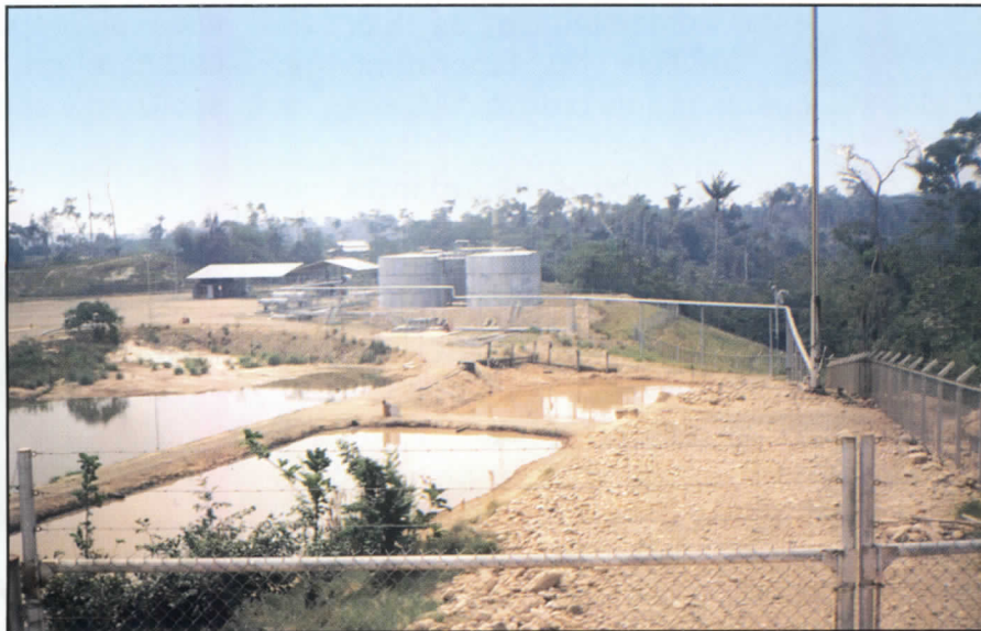
Instalaciones de un campo de producción
