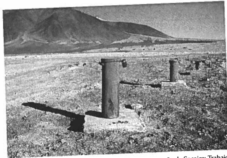
Laguna Tuyajto, en el territorio de la comunidad atacameña de Socaire: Trabajo de prospección de aguas subterráneas para Minera Escondida (Fotografía de Félix Bagazgostía, 2007).
