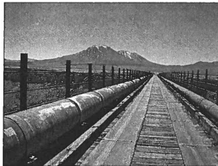
Puente Conchi, sobre el río Loa: tuberías que conducen el agua de la cuenca del río San Pedro hasta Chuquicamata.
